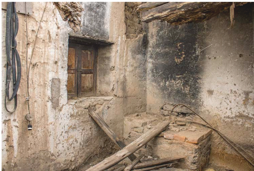
C3F19 DETALLE Interior de antigua cocina separada de la casa. Destaca el cemento de ladrillo que se usaba para cocinar con fuego y los muros pintados con cal.
