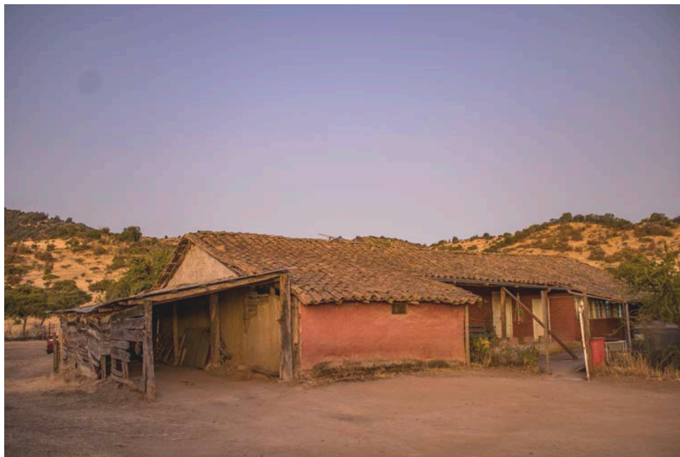
C1F1 CONTEXTO La casa emplazada en la loma da la espalda al cerro Trinidad y orienta su fachada principal hacia el camino público.
