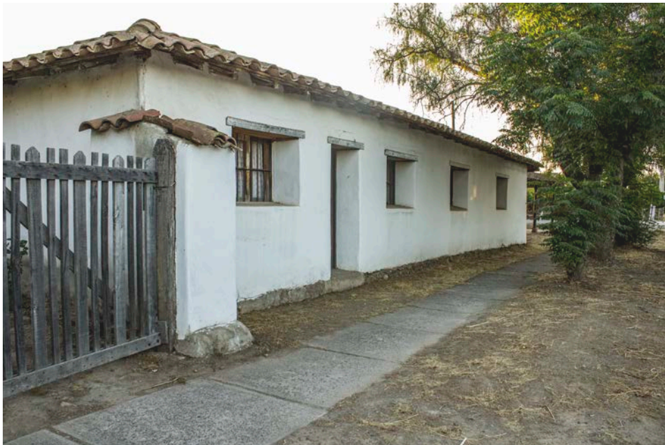
C4F2 FACHADA NORTE Volumen independiente funciona como cierre del patio interior donde transcurre la vida íntima de la casa. Originalmente este muro no tenía ventanas, estas son una modificación posterior"
