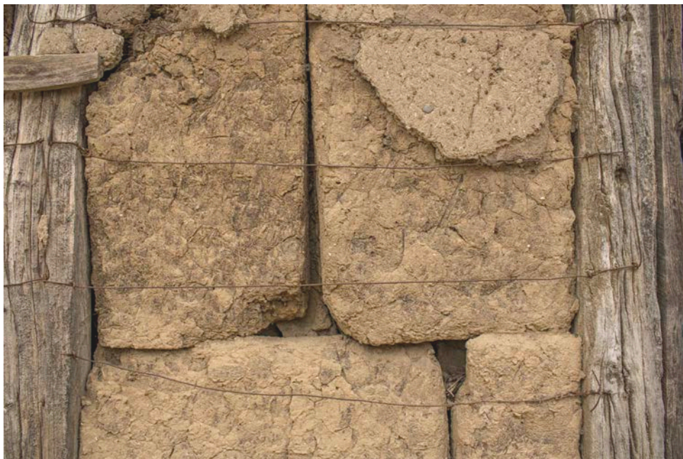
CF9 PANDERETA DE ADOBE Adobes verticales afirmados con alambre entre pies derechos de un tabique. Casa familia Silva.
