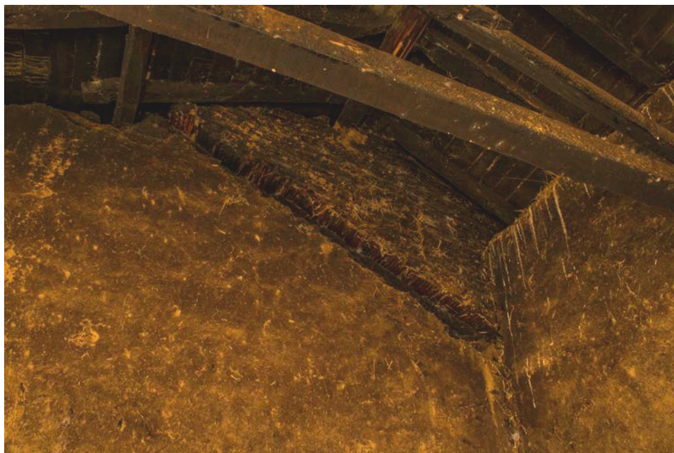
C5F11 DETALLE Techumbre de la cocina desde el interior. Se puede ver una línea diagonal en el muro que es la antigua pendiente de este recinto que luego fue remodelado. En la imagen se ve una línea de cañas que quedaron entre los adobes.
