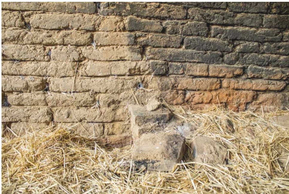
C5F14 DETALLE Cimiento de piedra y adobe encontrado en el pasillo, este era usado para cocinar. En la imagen se puede ver el adobe enrojecido producto del calor y otra sección tiznada producto del humo.
