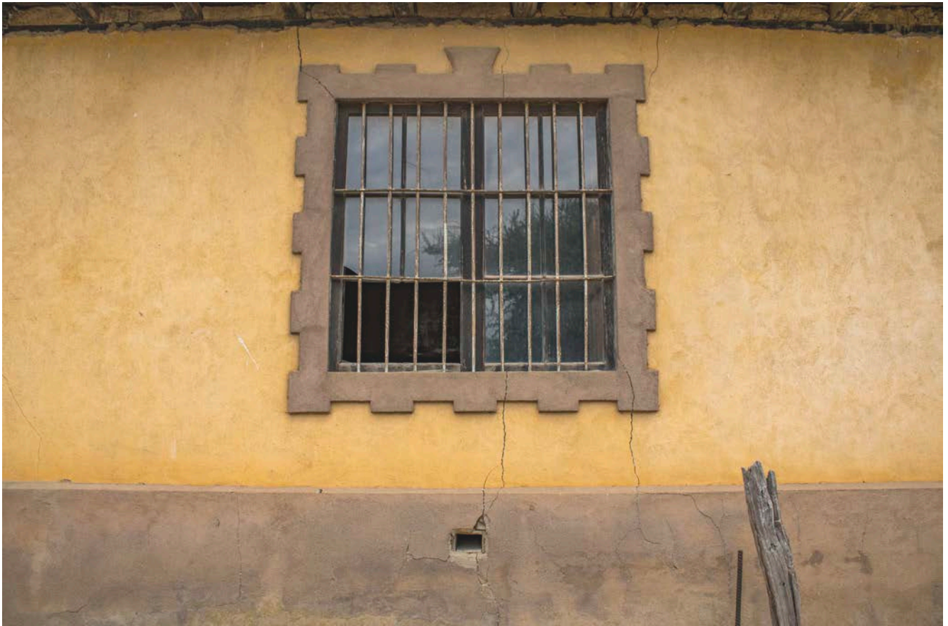
C3F11 DETALLE Escotilla de ventilación en zócalo y estuco de cemento con decoraciones en ventana. Vista desde el exterior de la vivienda
