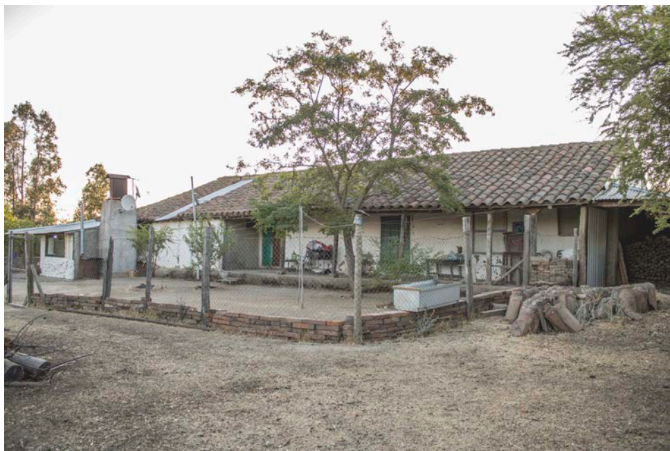
C1F2 FACHADA ESTE El corredor vinculaba la fachada sur con la fachada este. Luego del terremoto de 2010 se usó parte de este corredor para ampliar la cocina y construir un baño.
