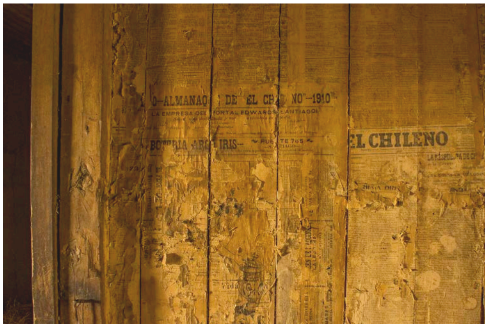
C5F9 DETALLE Tabique divisorio interior empapelado con periódicos antiguos
