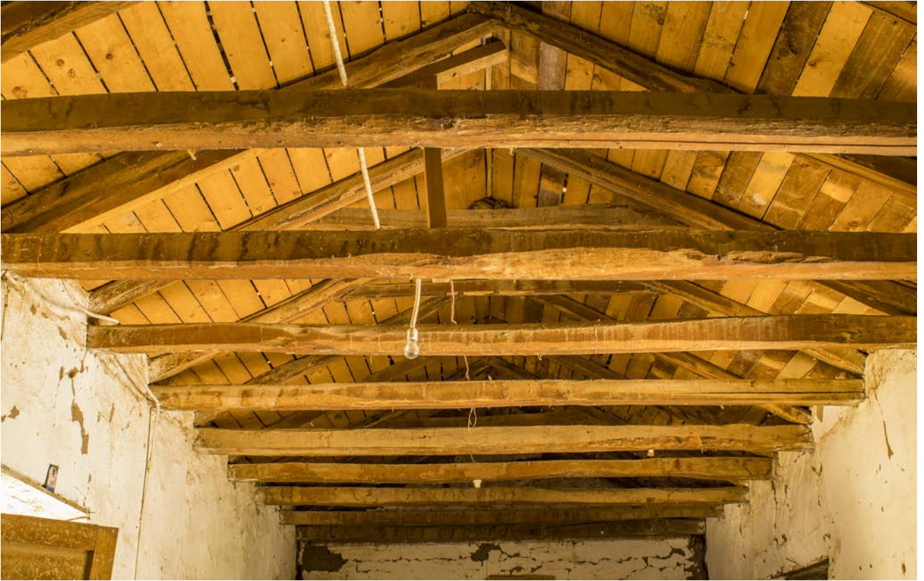
C1F15 DETALLE Estructura de vigas de álamo originales, labradas a mano. Las maderas de la cubierta estaban en mal estado y se reemplazaron por tablas de pino.
