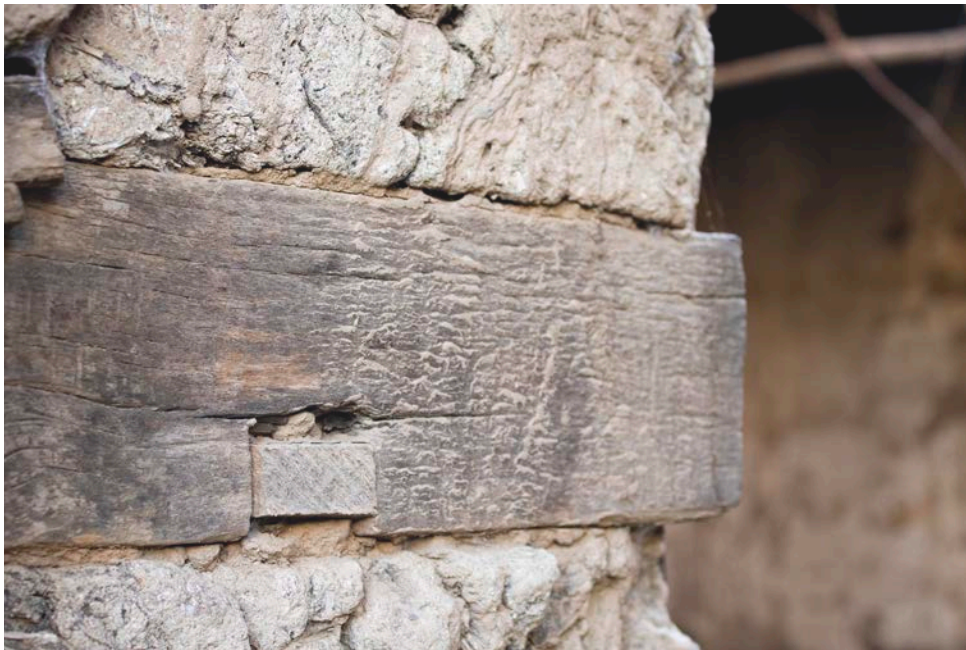
CF16 ZOQUETE Pieza de madera emprotrada en el muro para anclar marco de la puerta.
