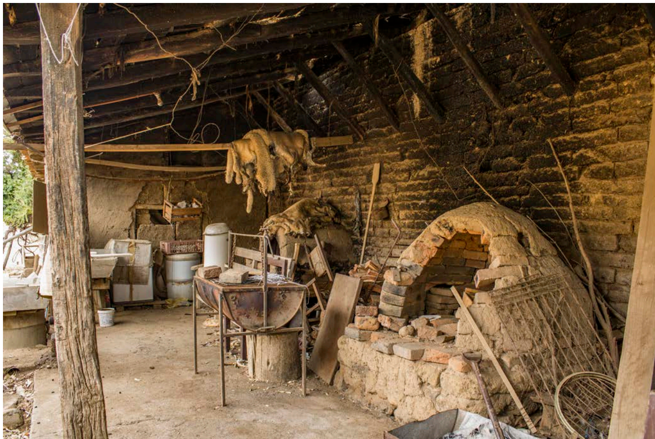
C3F16 DETALLE En el galpón se encuentra un antiguo horno para hacer pan, construido con ladrillos de arcilla cocida sobre base de adobe.
