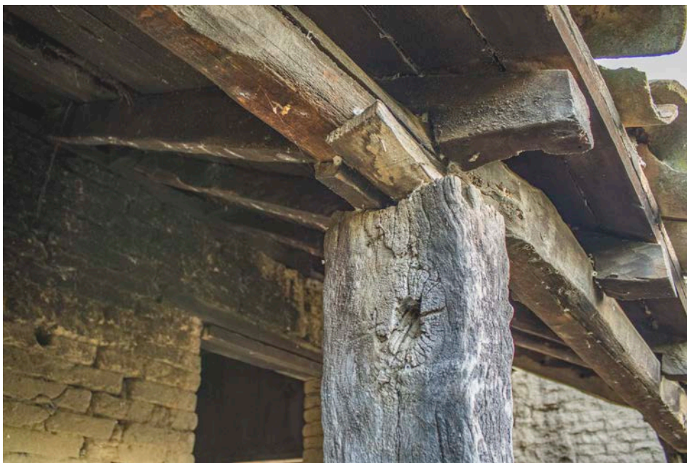
C5F15 DETALLE Pilar, solera y viga con encaje que sostienen el techo del corredor trasero.
