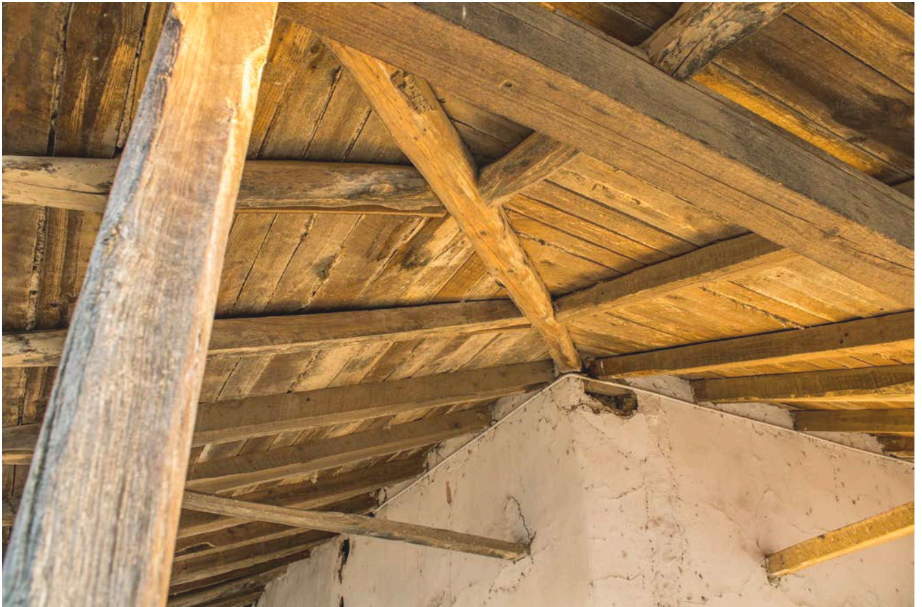
C4F7 DETALLE Encuentro de vigas de techo en esquina del corredor.
