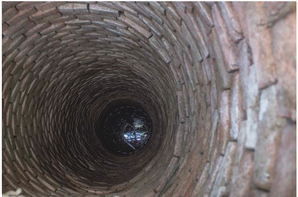
C5F17 DETALLE Interior de la noria revestida con ladrillos de arcilla cocida.
