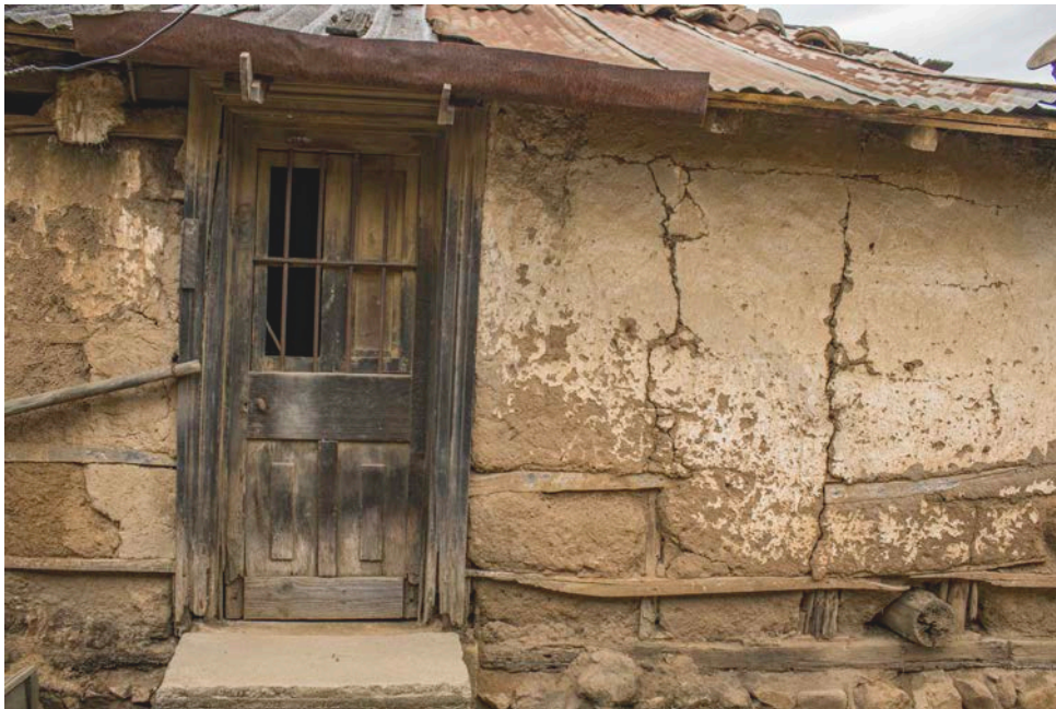
C3F13 FACHADA SUR OESTE Muros perimetrales de tabiquería de madera con adobes verticales y pintura de cal en fachada suroeste.
