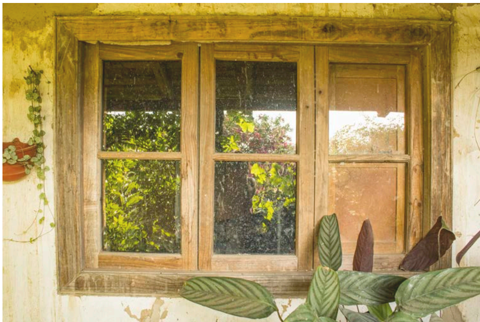
C2F9 DETALLE Ventana de madera de álamo en corredor.
