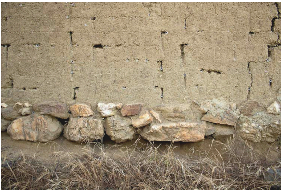
CF10 SOBRECIMIENTO Sobrecimiento construido con piedras angulosas con alto contenido de cuarzo que abundan en los lomajes de Marchigüe. Casa G. Lizana.
