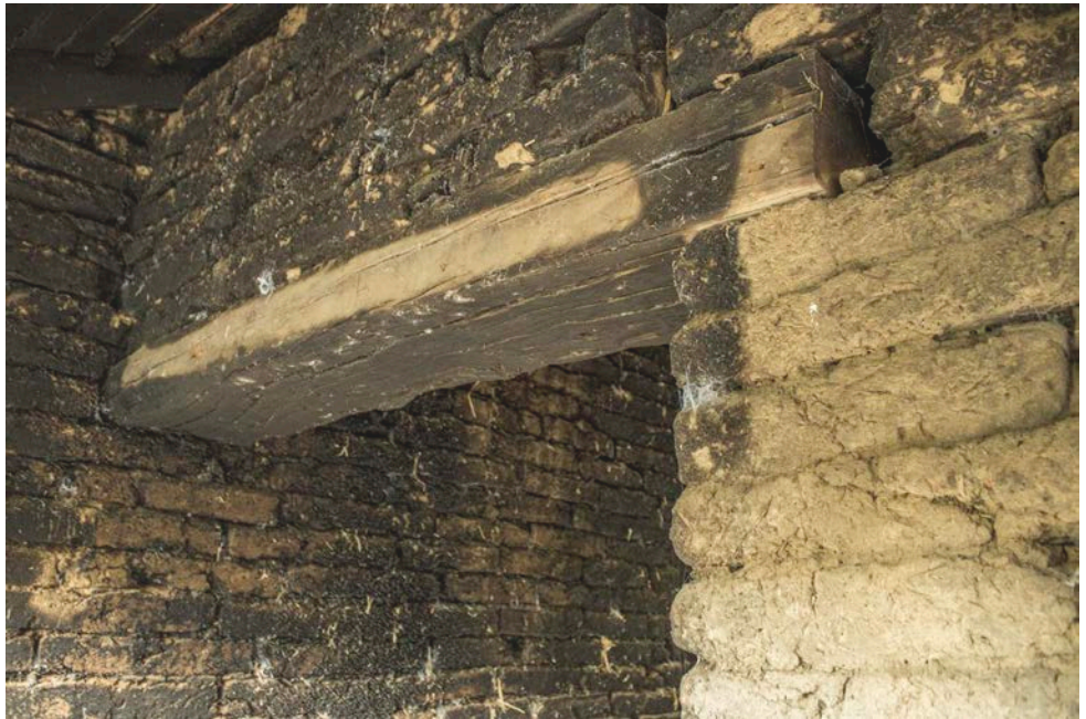
C5F16 DETALLE Dintel de sección 0,4 x 0,16 m. penetra 0,2 m en el muro de adobe.
