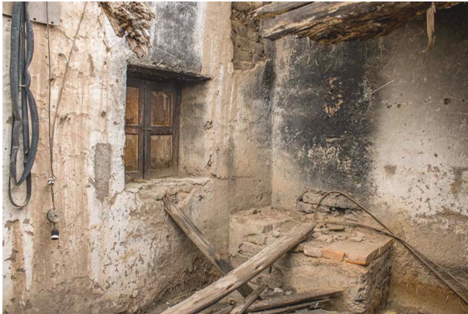
CF24 COCINA DE CIMENTO Cocina exterior semi derrumbada y "cocina de cemento" hecho de adobe sobre el cual se encendía fuego. En la imagen se pueden ver las murallas tiznadas y los adobes superiores cocidos. Casa familia Silva Silva.
