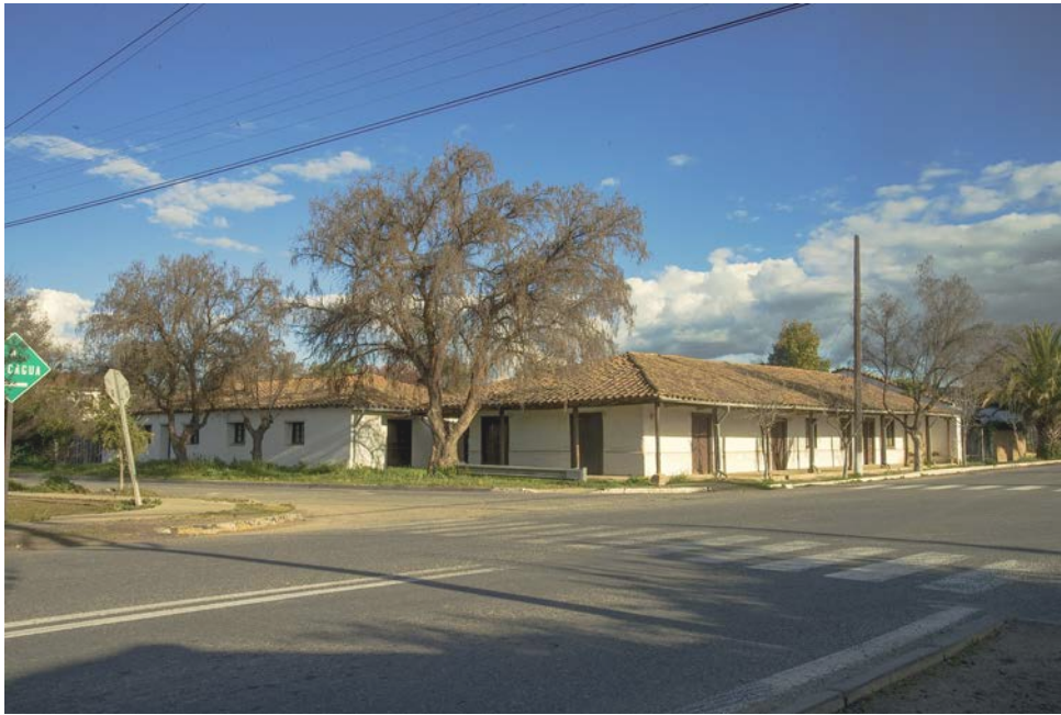
C4F1 FACHADA PRINCIPAL Y CONTEXTO Emplazamiento en esquina. Fachada con corredor, mira hacia la calle principal del pueblo.
