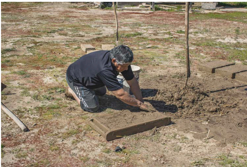
CF6 FABRICACIÓN DE ADOBES Maestro Gabriel Núñez alisando la superficie del adobe fresco con la mano y se presionando las esquinas.
