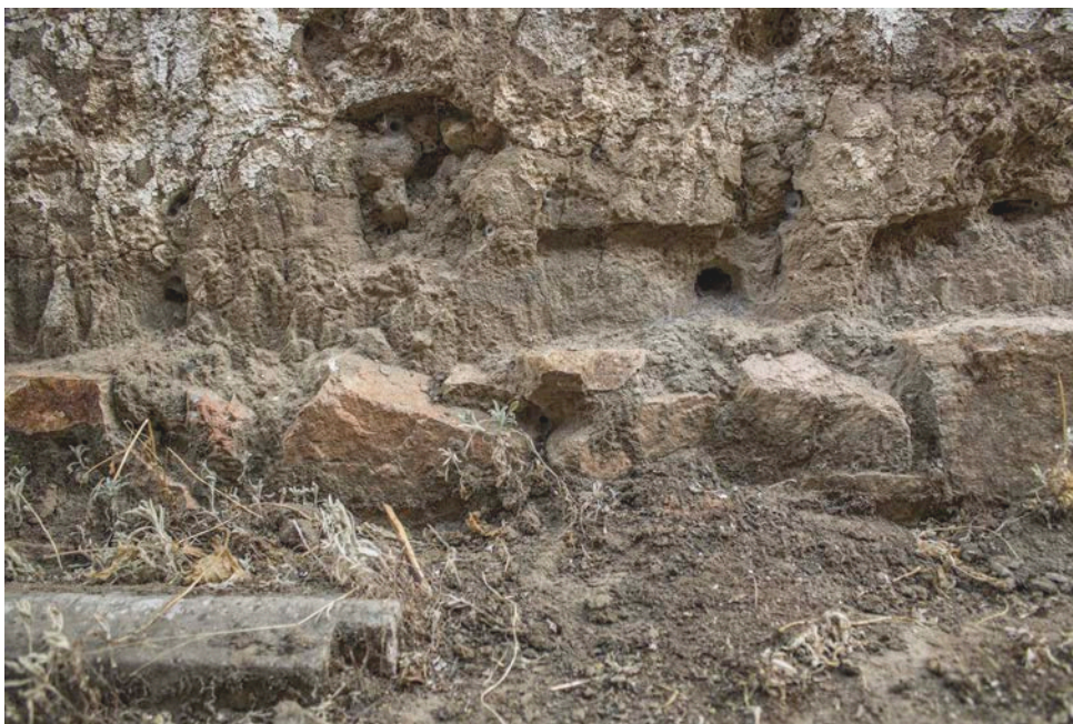
C4F18 DETALLE Sobrecimiento en cocina exterior. Piedras pegadas con barro, la parte inferior del muro presenta desgaste por erosión.
