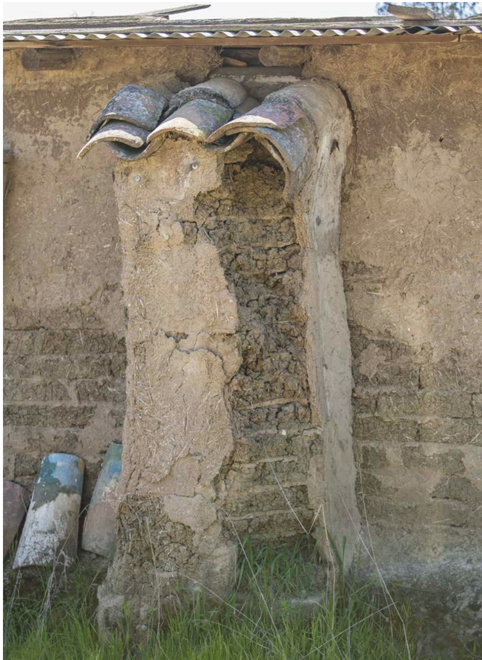
CF19 CONTRAFUERTE Contrafuerte encontrado en la ex fábrica de adobes de don Hernán Núñez. Su cara superior se protege por medio de tejas.
