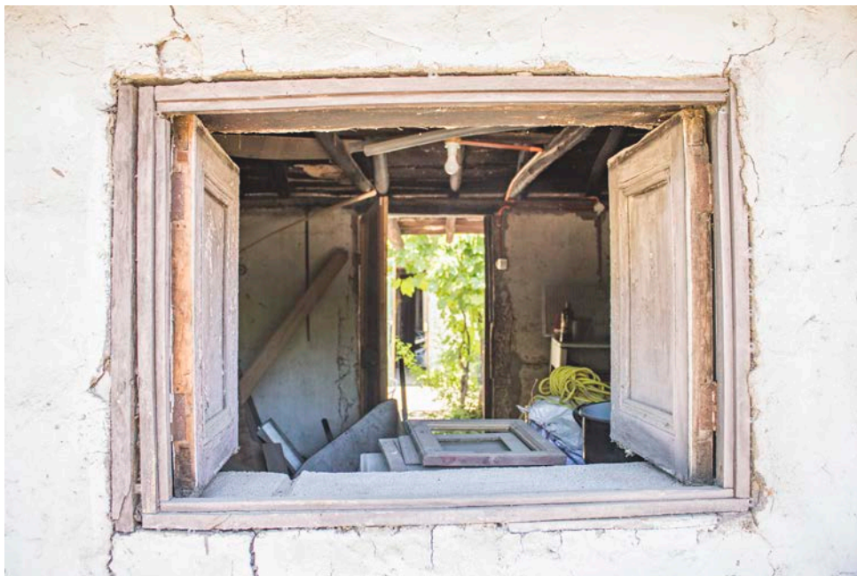
C4F17 DETALLE Pequeña ventana de la cocina exterior hecha de madera de álamo, con postigos y sin vidrios.
