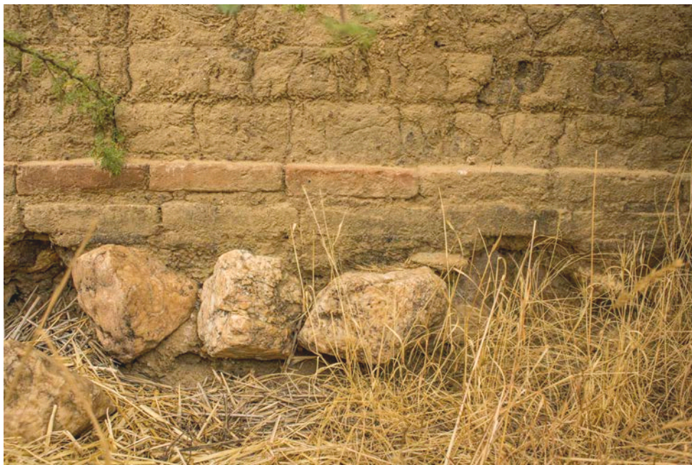
C5F7 DETALLE Sobrecimiento de piedra y ladrillo sobre el que se posan los adobes.
