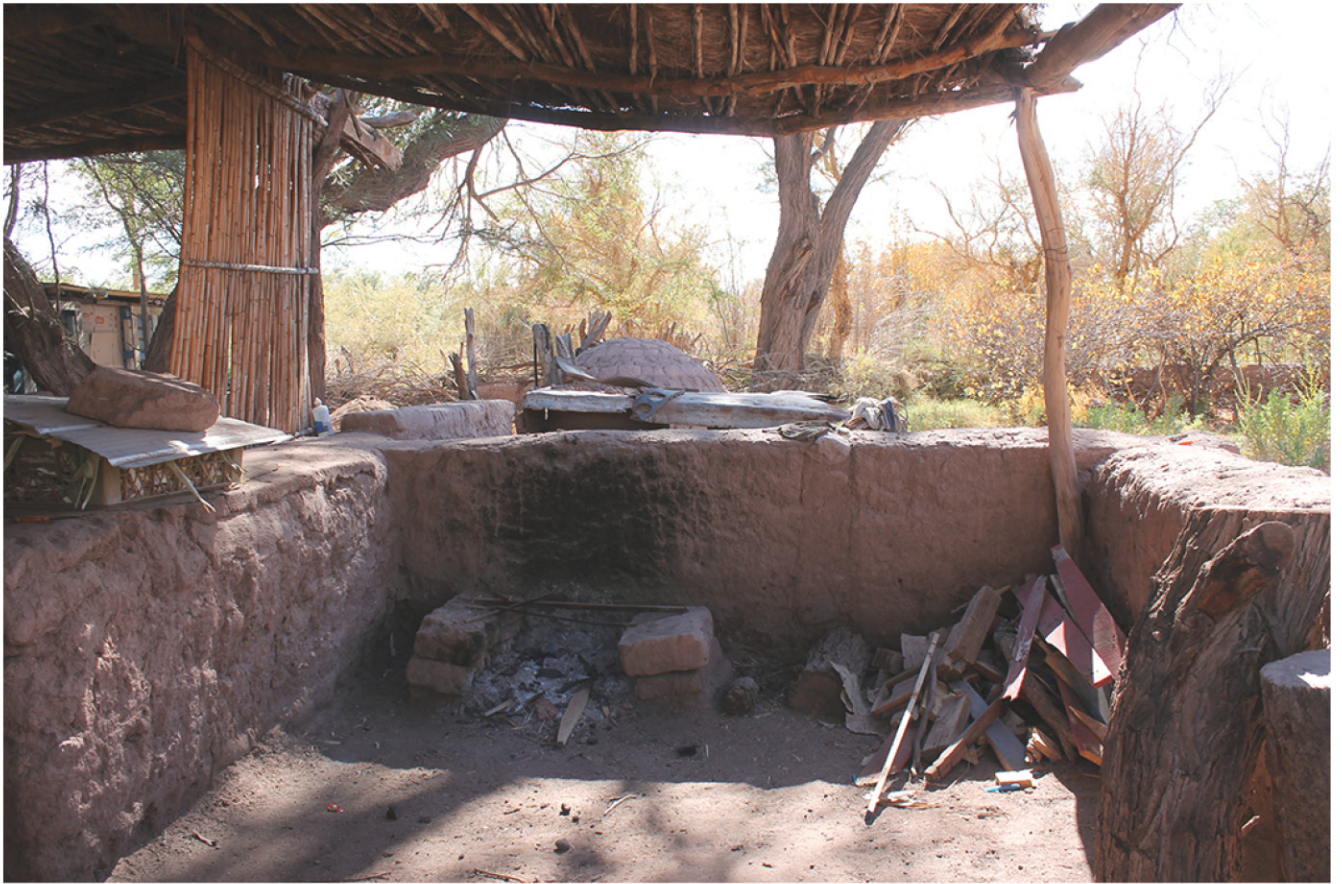
C3F8 ESPACIO RELEVANTE Muro perimetral de tapial a media altura en cocina exterior, lugar del fuego y sombreadero.
