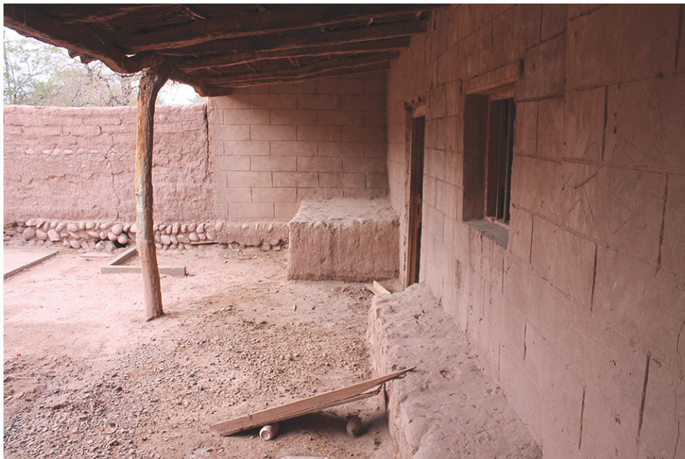
C6F8 DETALLE Elementos exteriores construidos en adobes; poyos de asiento, corredor y plataforma utilizada como mesón.
