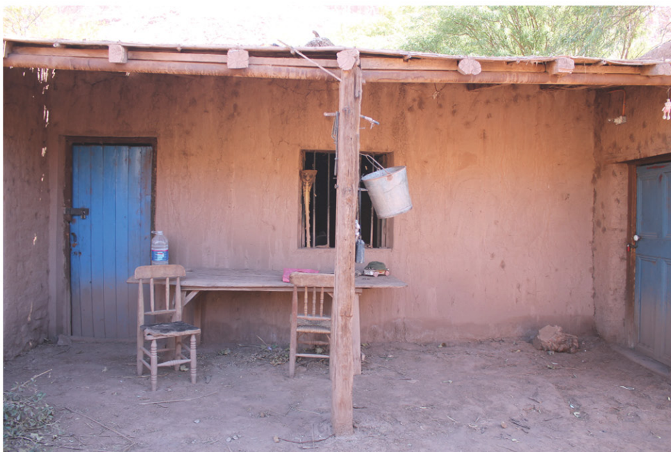
CYR033 CORREDOR Espacio recibidor, articulador y generador de la forma de la casa atacameña.
