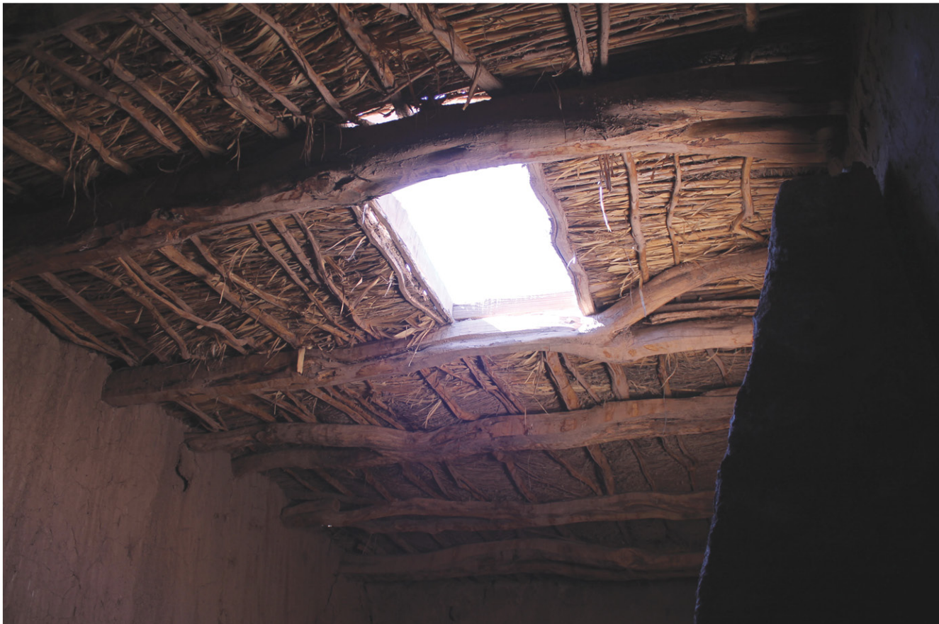
CYR023 LUCARNA Elemento común de iluminación natural cenital a través de una lucarna encontrado en casa García ubicada en el Ayllu de Catarpe. (Véase Caso 1)
