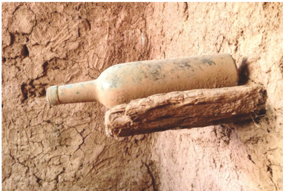
CYR026 MUEBLE EN OBRA Madera de cactus con concauidad empotrada a muro estructural de la vivienda destinada a recibir botellas.
