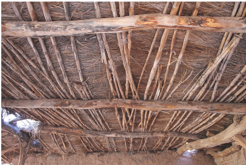
C3F9 DETALLE Cielo de acceso a vivienda construido con vigas de chañar, cielo de caña y paja esporal.
