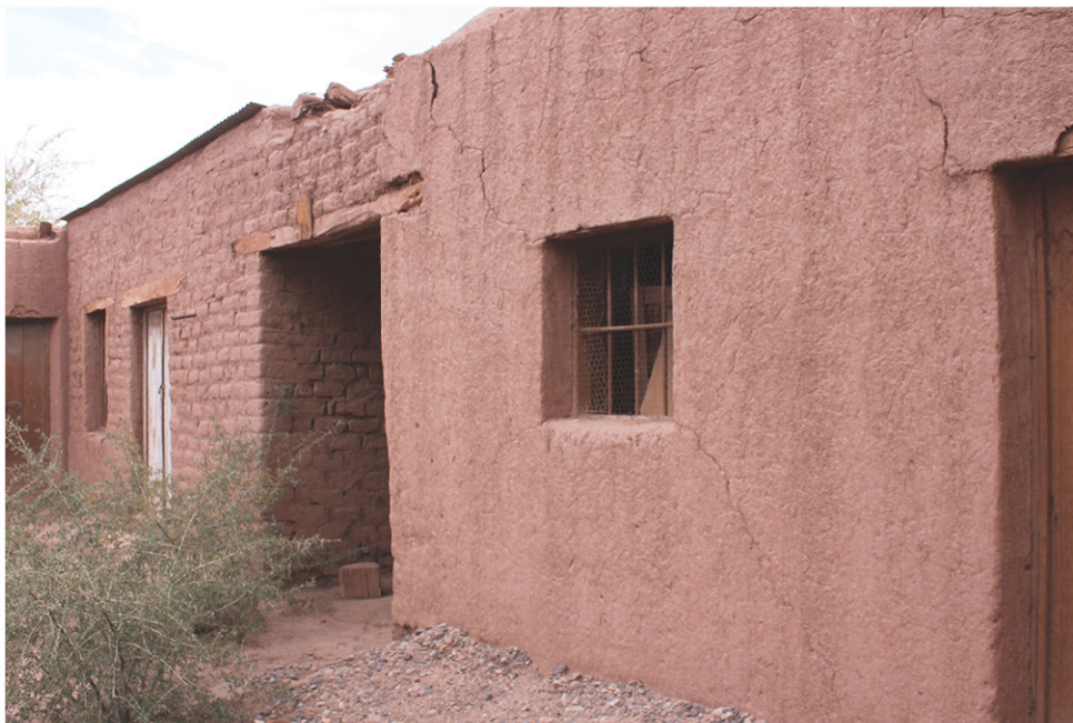
C2F3 DETALLE Fachada interior sur vista desde el patio central. Destaca el buen estado del revocho de los muros.
