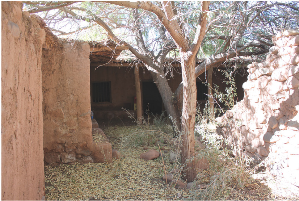
C1F3 ESPACIO RELEVANTE Acceso por patio interior de la vivienda.
