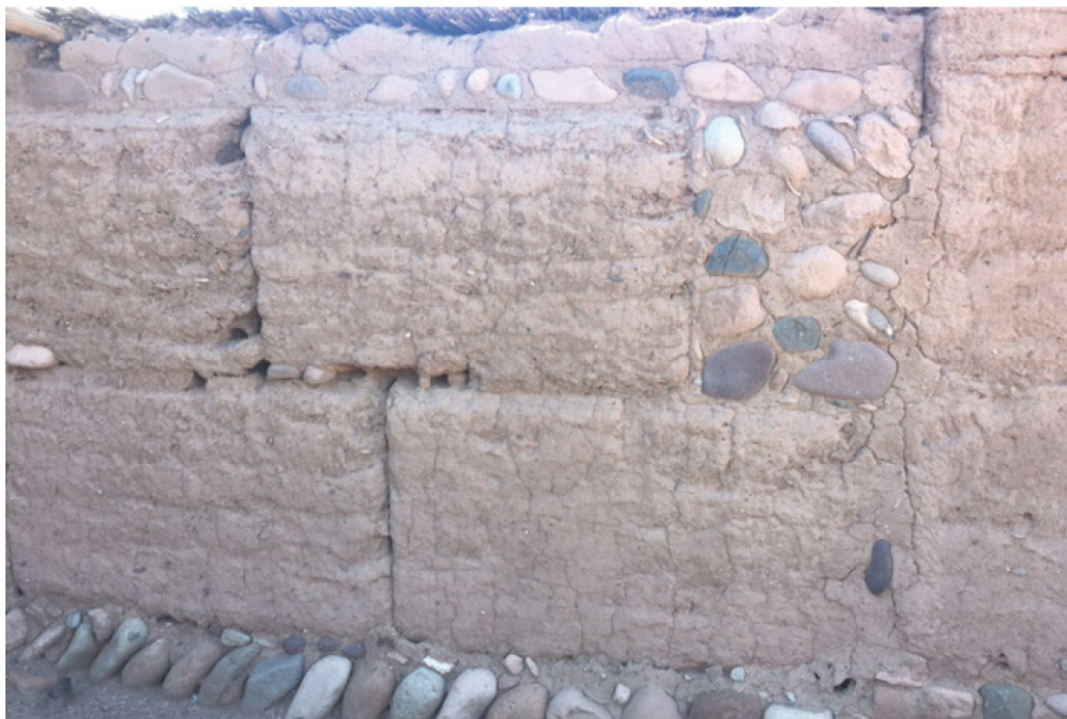
CYR04 TAPIAL Muro de tapial con sobrecimiento, juntas de dilatación y cadena de piedras, estas también eran usadas por el constructor para adherir tapia con tapia.
