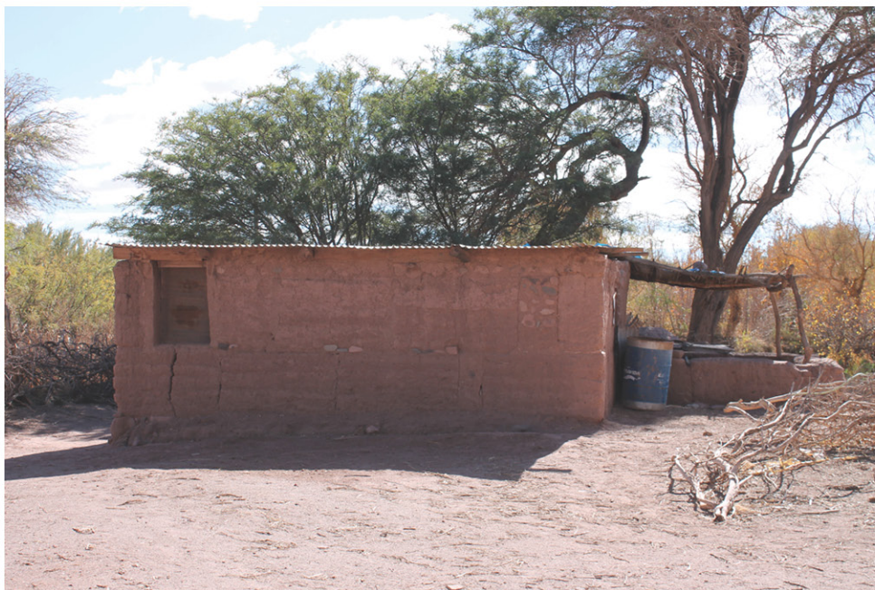
CYR05 TAPIAL Vista lateral casa Mamani construida en tapial ubicada en el Ayllu de Yaye. (Véase Caso 3)
