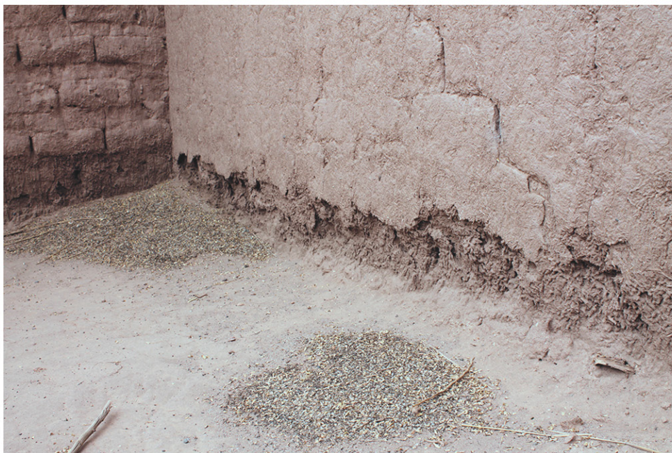
C2F4 DETALLE Debido a la ausencia de sobre cimiento de piedra, y al revote de la caída de agua se muestra la base del muro erosionada por la humedad, daño frecuente en estas casas.
