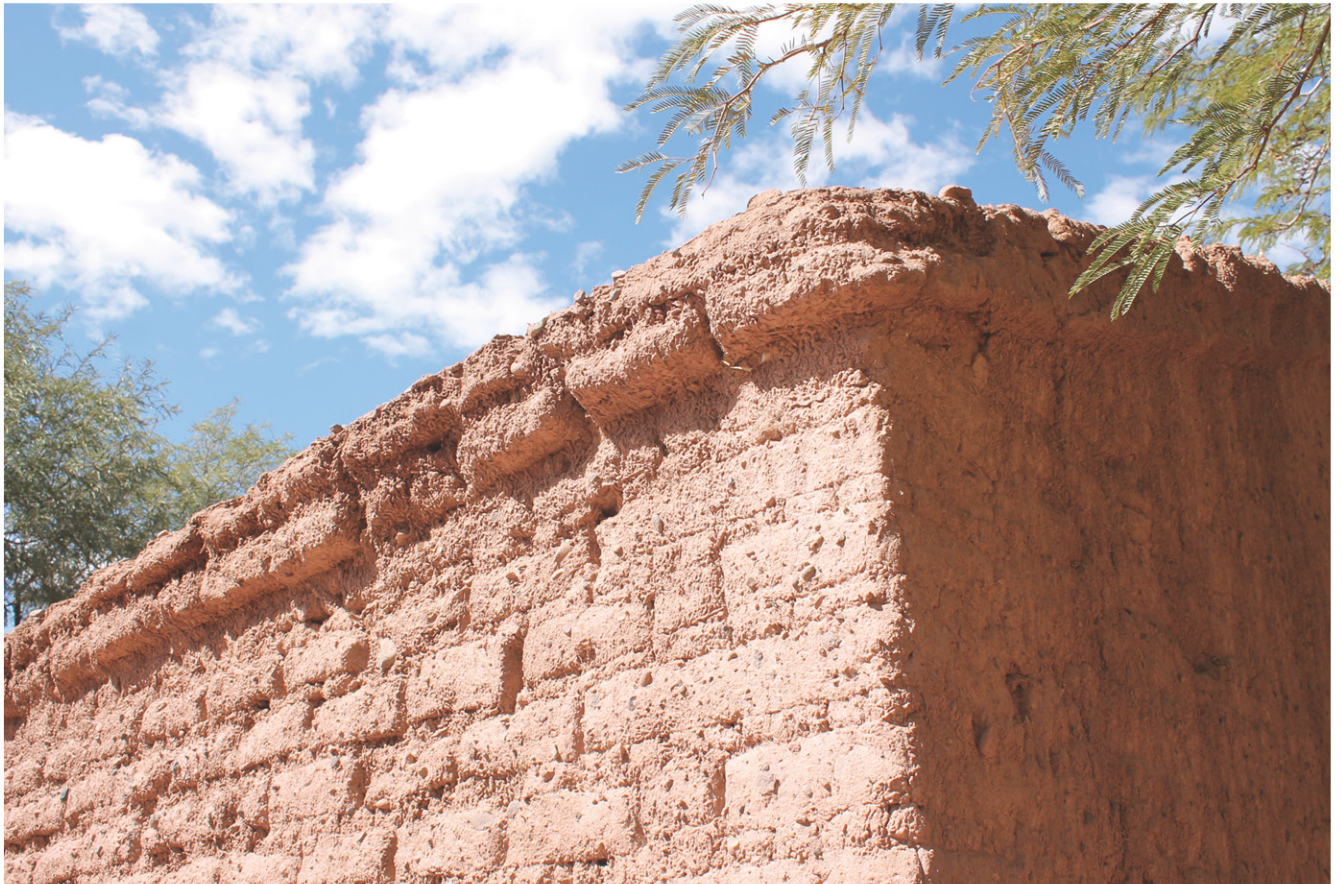
CYR031 CORONAMIENTO Alero construido con piezas de adobe como coronamiento de la techumbre encontrado en vivienda perteneciente a familia Yutronich ubicada en el Ayllu de Quitor.
