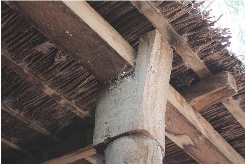
C1F4 DETALLE Pilar de chañar labrado sostiene alero con cielo de brea.
