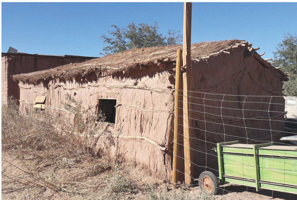
CYR012 QUINCHA Quincha encontrada para construir la cocina de la casa de los abuelos de Orlando Martínez en Ayllu de Coyo, la quincha fue construida con cañas y revoque de barro.
