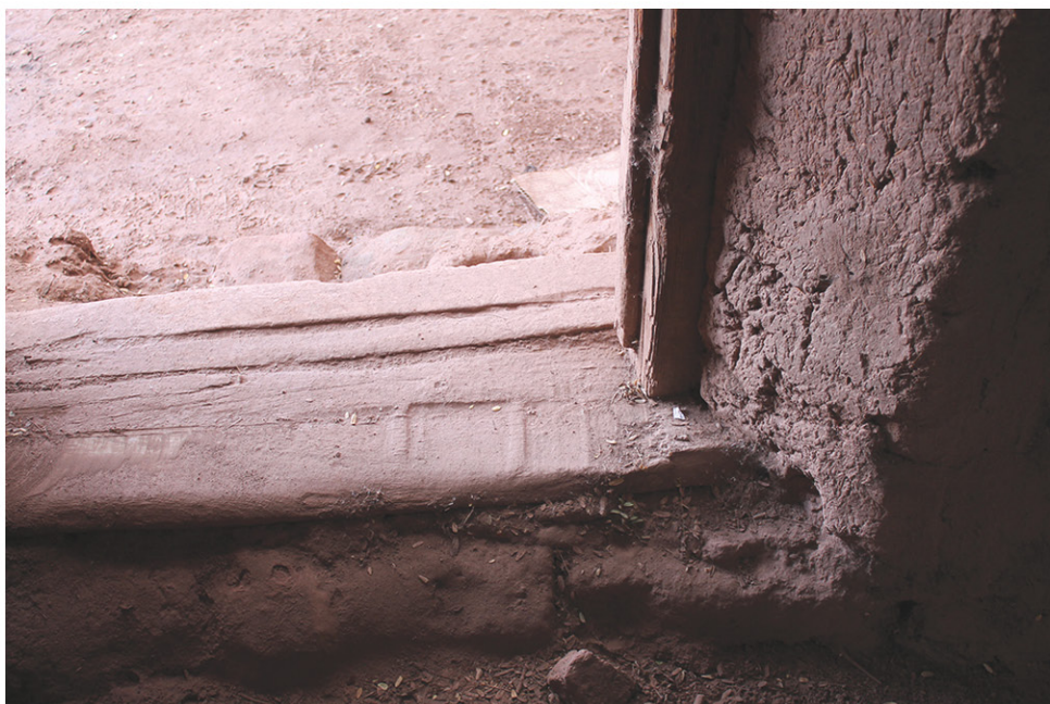
C4F4 DETALLE Vista inferior del ensamble de maderas verticales y horizontales para construir el marco de puerta, ubicado a una altura de piso acabado superior al nivel de acceso a la vivienda.
