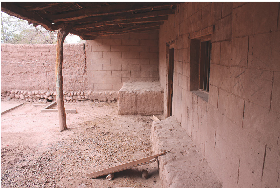
CYR032 POYO O AIENTO EN OBRA Al fondo, plataforma construida del mismo modo que el poyo fue utilizada como mesón en obra en casa Navea ubicada en el Ayllu de Solcor. (Véase Caso 6)
