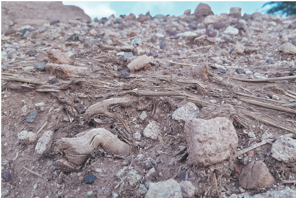
C5F9 DETALLE Técnica de "torta de barro" con presencia de piedrecillas sobre la techumbre de brea.
