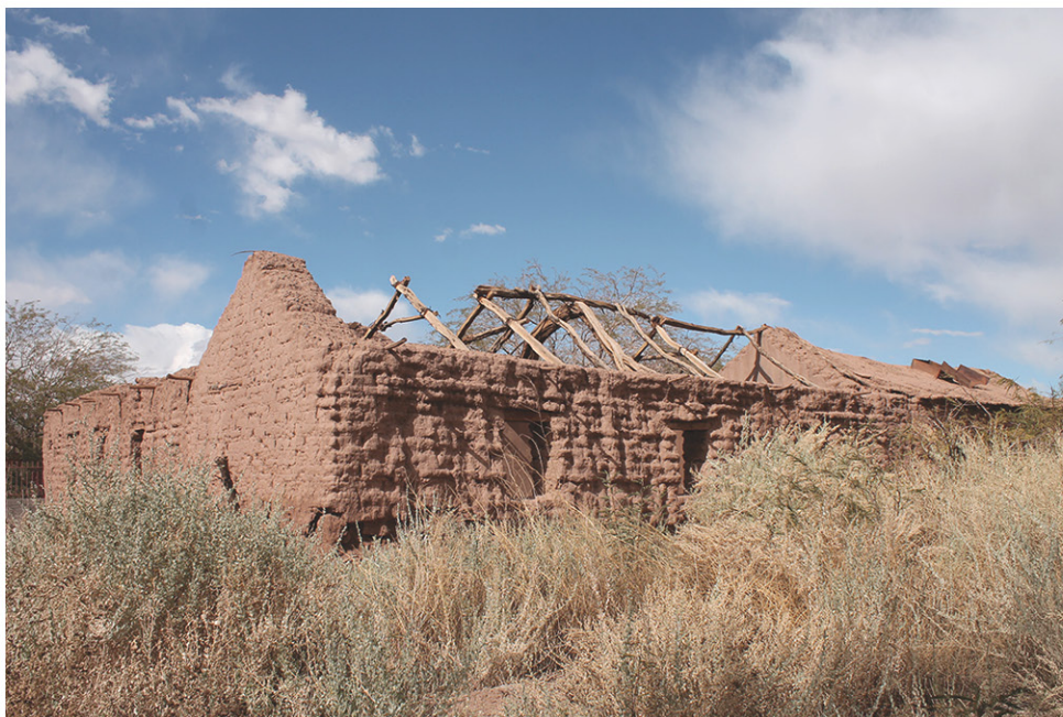
C6F2 FACHADA PRINCIPAL Tímpano incluido al muro. Aparece la estructura de techo compuesta por pares y nudillos de chañar. El ancho del muro se construye con el lado de mayor espesor del adobe
