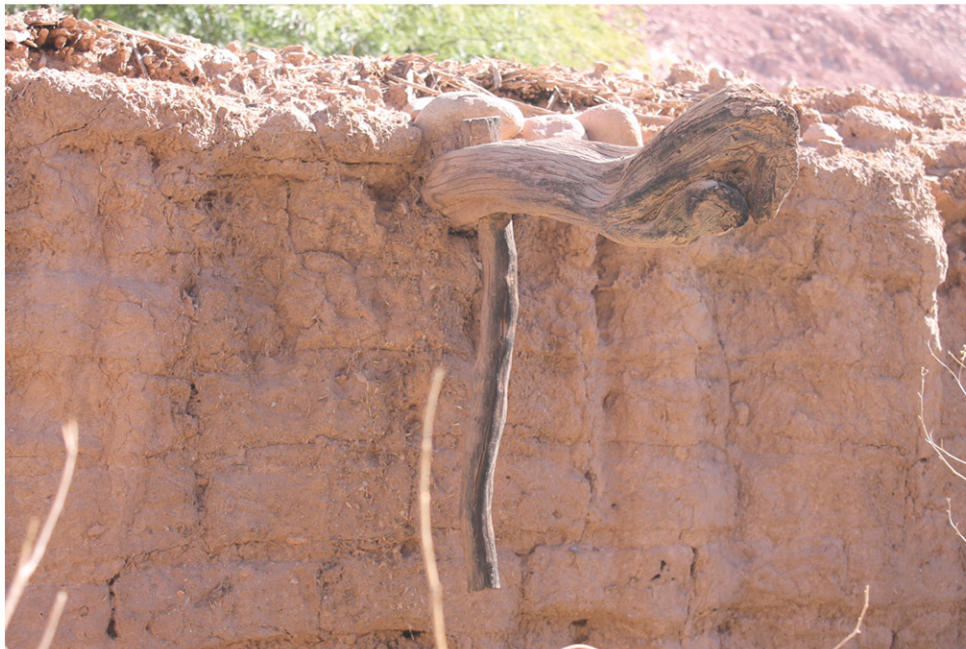
C1F12 DETALLE Traba de chañar para viga principal de techumbre.
