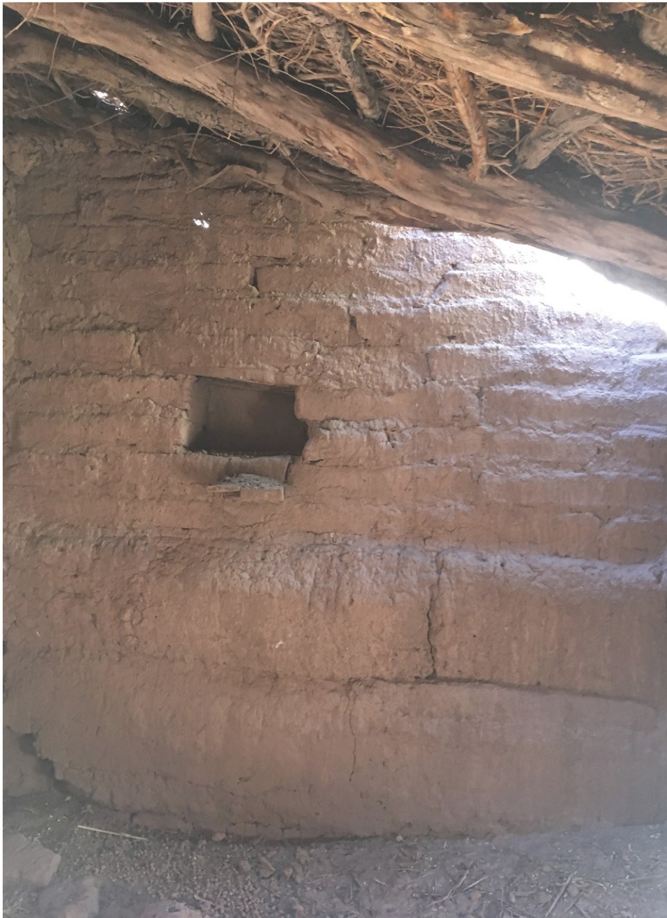
CYR010 TÉCNICA COMPUESTA Se repite el fenómeno de casa que nace como un corral en la técnica de tapial continuándose en adobe para conformar la casa, vista de un interior con mueble en obra.
