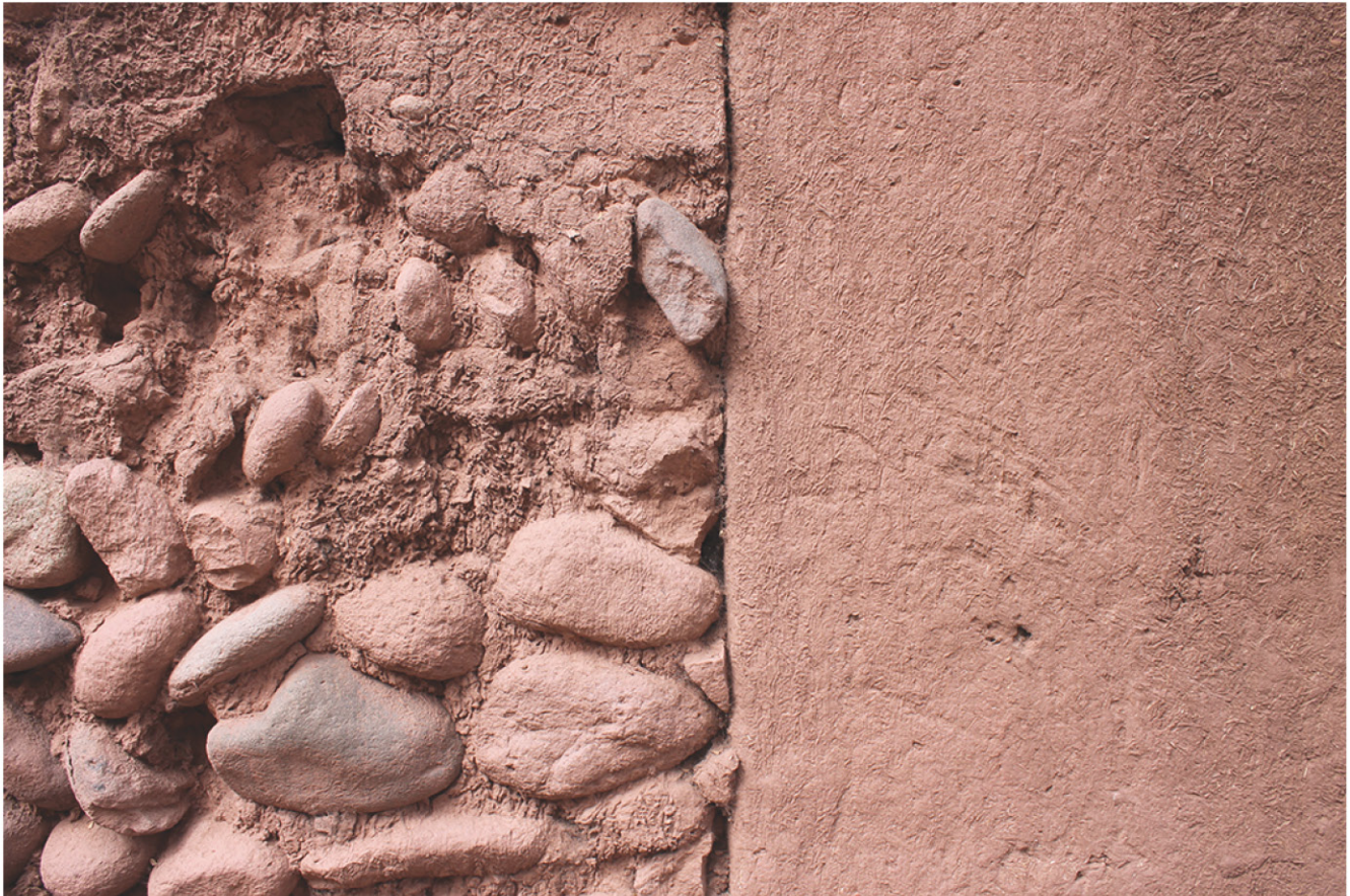
C4F8 DETALLE Encuentro de muros construidos con diferentes técnicas de tierra: mampostería de piedra con mortero de barro y adobe revocado.
