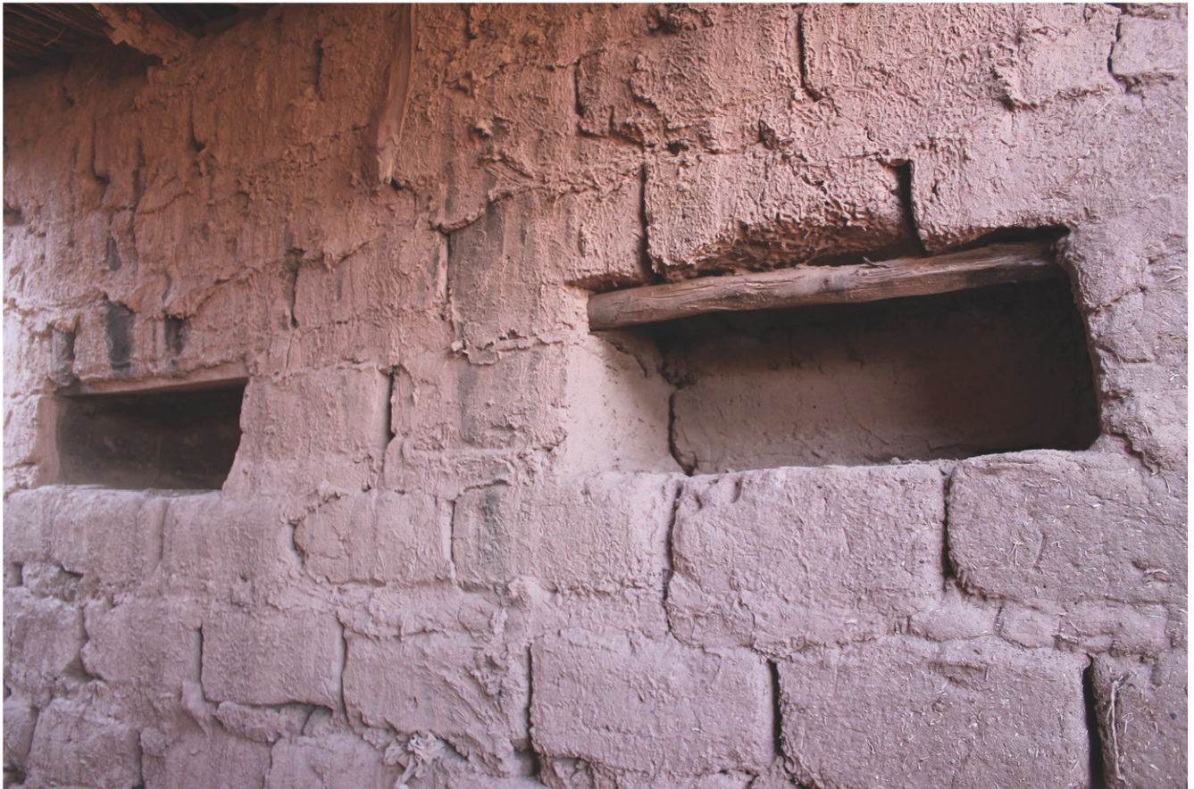
CYR024 MUEBLE EN OBRA Mueble en obra en muro de adobe en recinto destinado a cocina encontrado en vivienda ubicada en el Ayllu de Cucuter.
