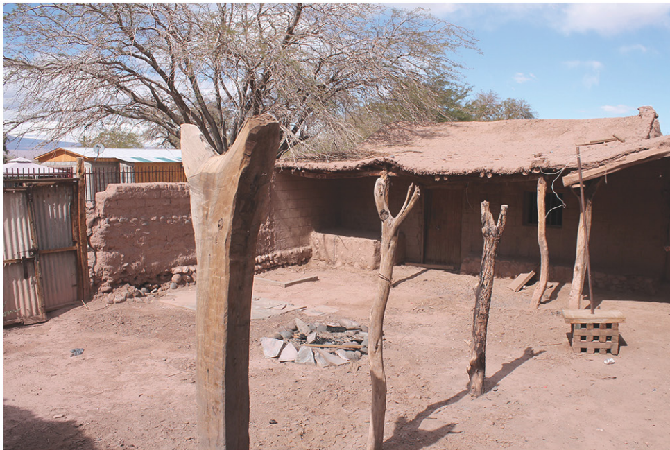
C6F7 ESPACIO RELEVANTE En el patio central de la vivienda aparecen pilares de chañar que fueron alineados para dar continuidad al corredor interior.
