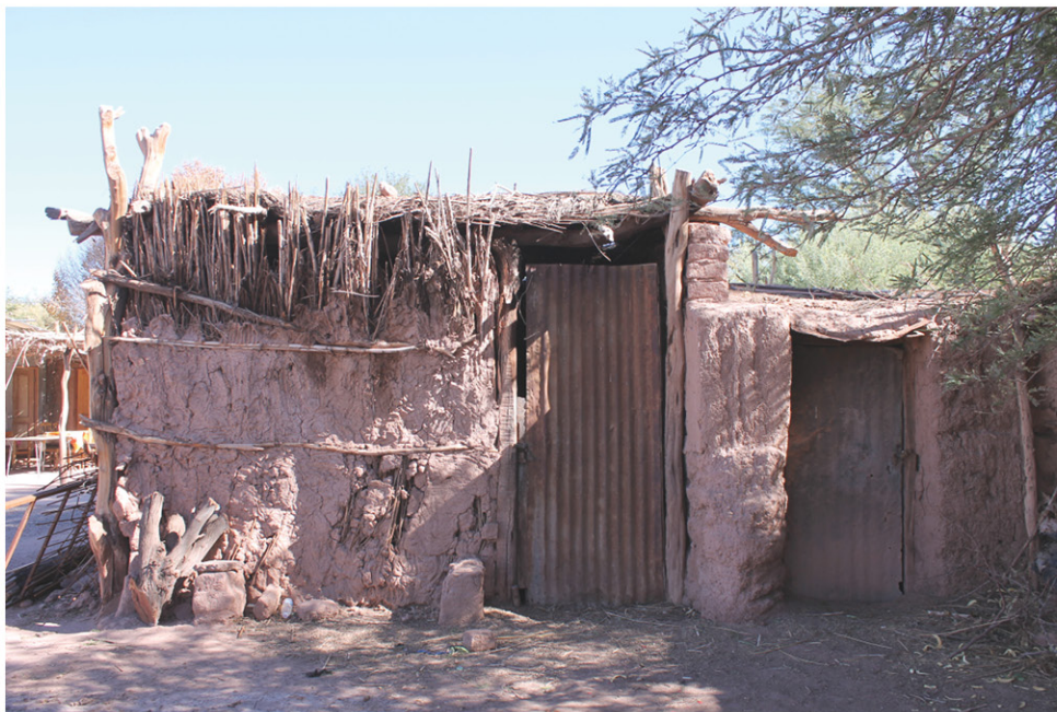
CYR011 QUINCHA Escuelita Coyo. La quincha de la escuela usa pies de derechos y costaneras de chañar con relleno de brea y revoque de barro.
