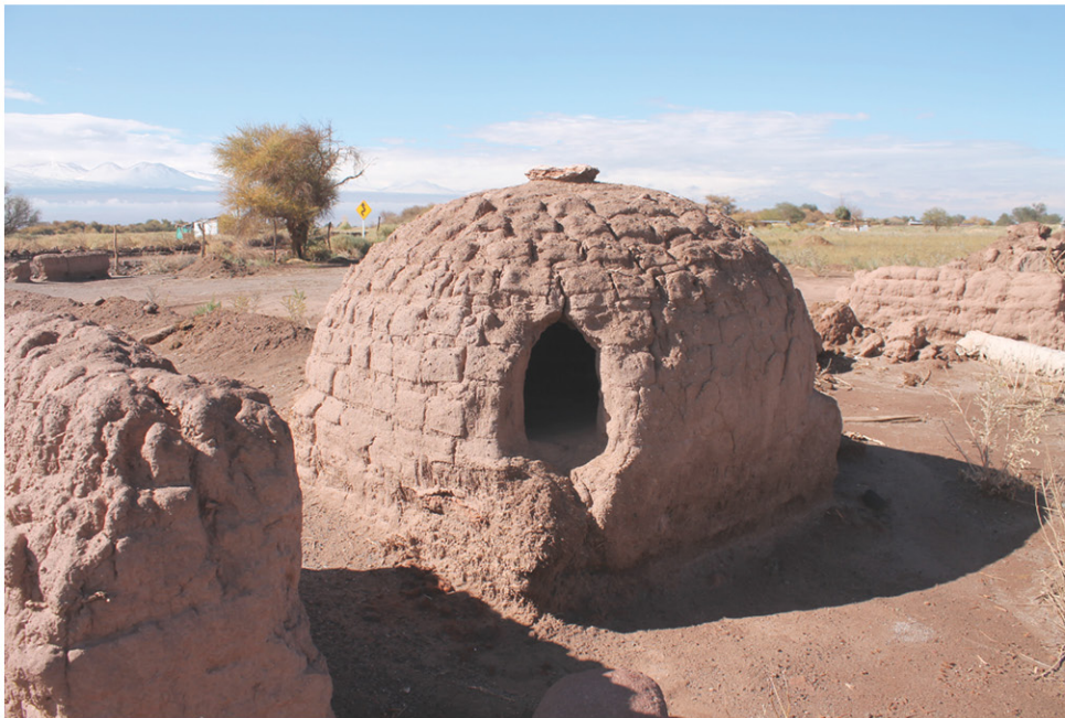
CYR036 HORNO Horno construido con adobes de formas trapezoidales encontrado en vivienda ubicada en el Ayllu de Cucuter.
