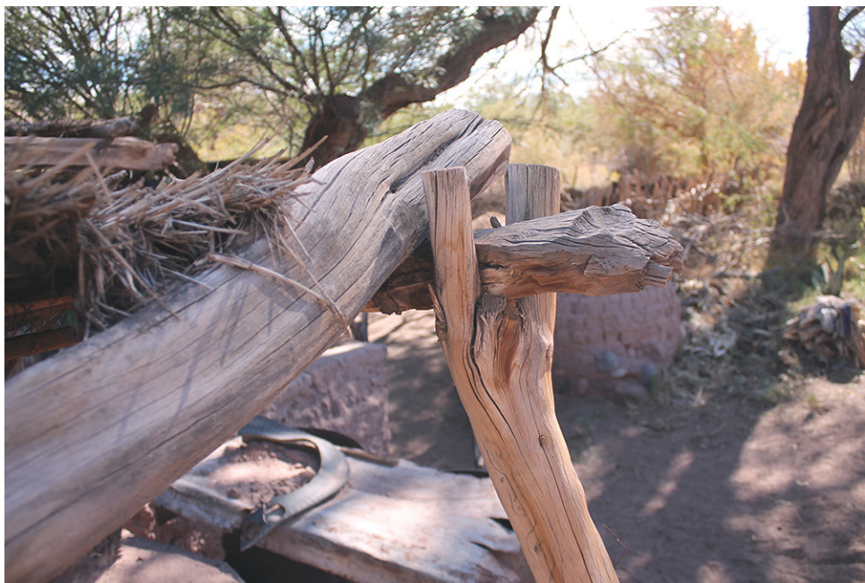
C3F10 DETALLE Encuentro de viga y pilar en "Y", usual en la casa atacameña.
