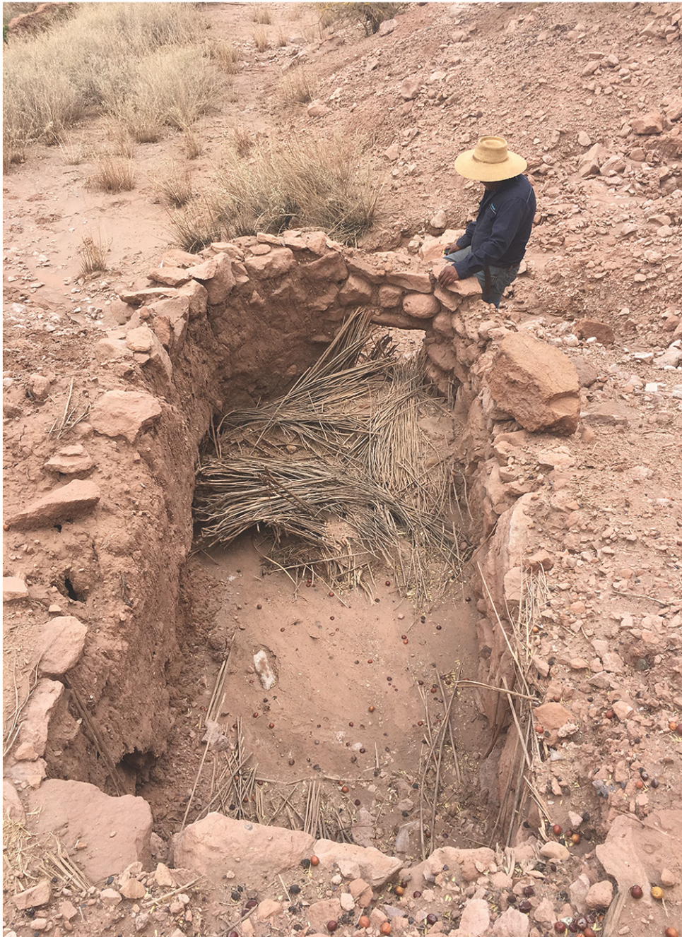
C4F13 ESPACIO RELEVANTE TROJA; corresponde a elemento constructivo destinado al almacenamiento de alimentos a baja temperatura, ubicado en ladera de cerro aledaño a la vivienda.
