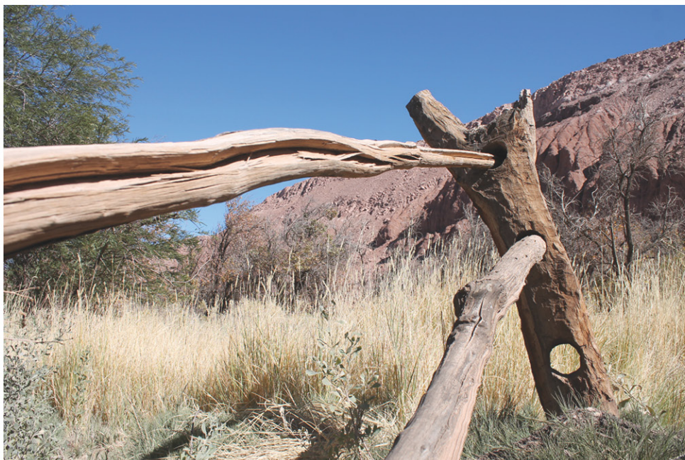
C1F13 DETALLE Ensamble manual a pilar de chañar. Acceso al predio donde se emplaza la vivienda.
